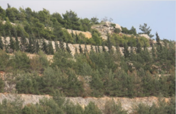
Εικόνα των βαθμίδων αποκατάστασης στο παλιό λατομείο του εργοστασίου στην Αγριά Βόλου
