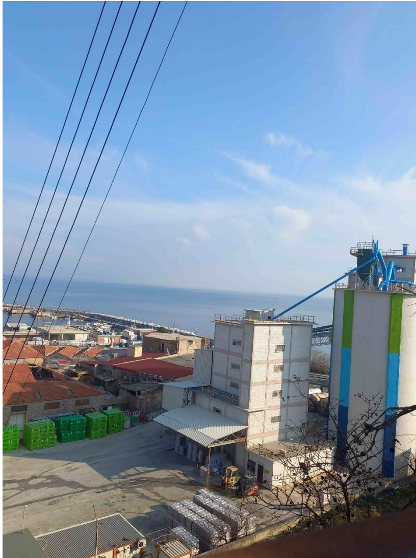
Φωτ. 1: Κέντρο διανομής Καβάλας, δυτική λήψη με προοπτική τη πόλη της Καβάλας και το κεντρικό λιμάνι.
