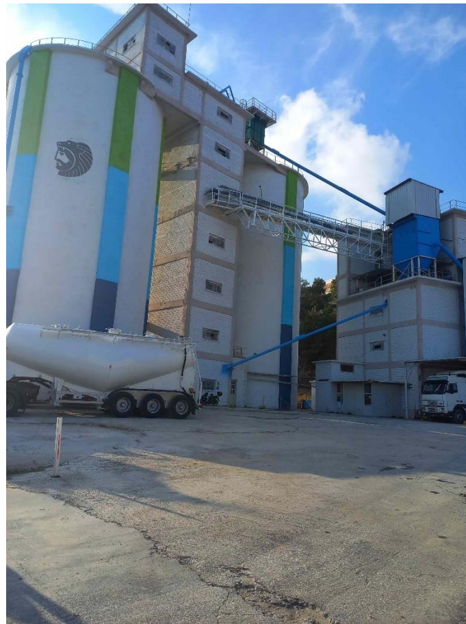
Φωτ. 3: Εσωτερικός χώρος του κέντρου διανομής, σταθμός φόρτωσης 1.
