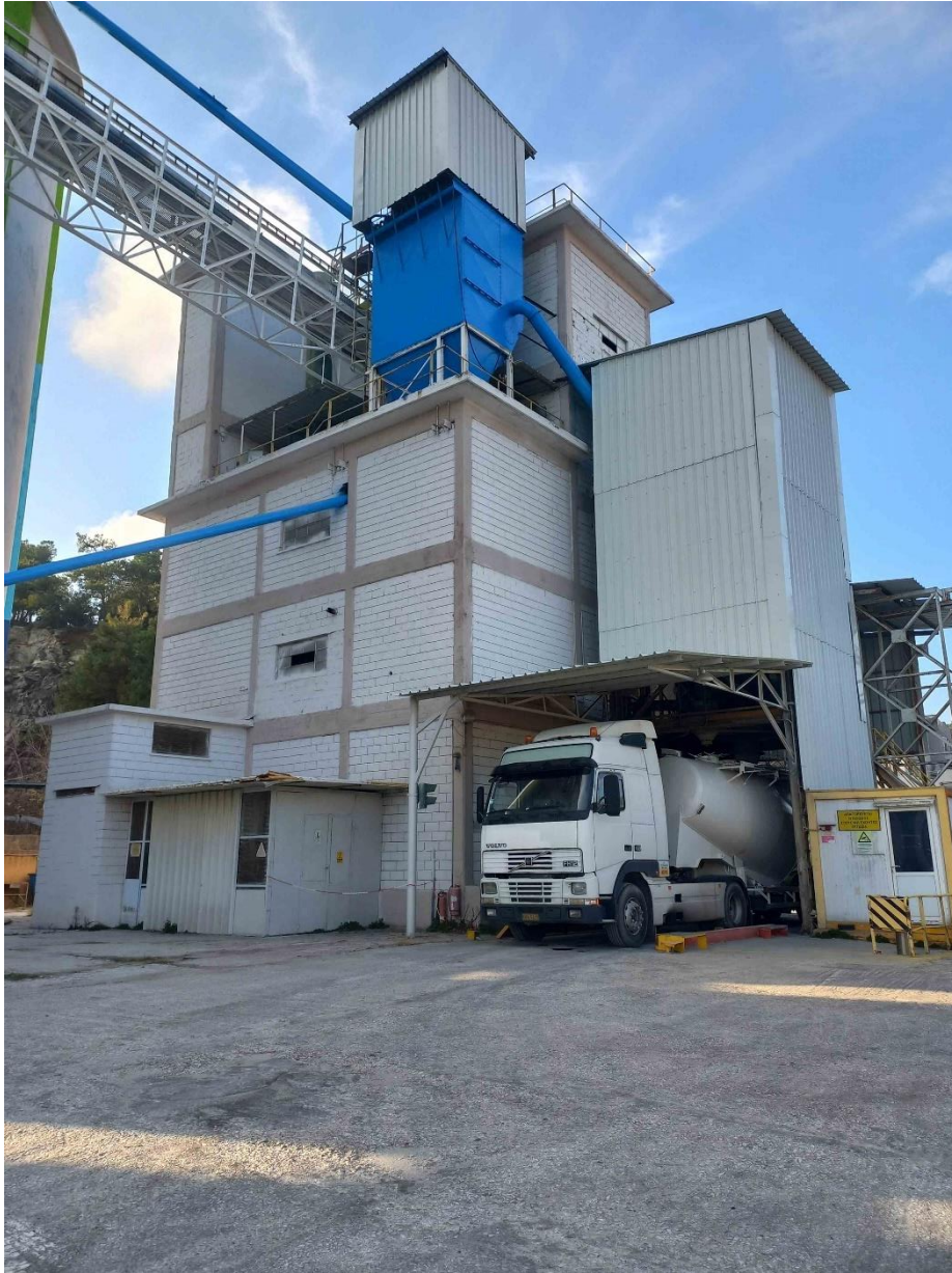
Φωτ. 4: Εσωτερικός χώρος του κέντρου διανομής, σταθμός φόρτωσης 2.
