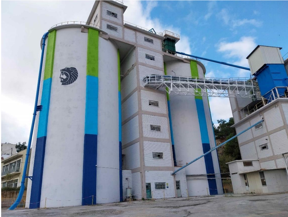
Φωτ. 2: Εσωτερικός χώρος του κέντρου διανομής. Τμήμα με τα κεντρικά σιλό παραλαβής του τσιμέντου .
