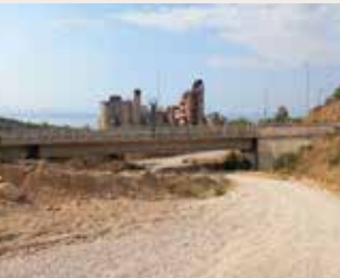
Αποκατάσταση του δρόμου και δενδροφυτεύσεις στο φρύδι του πρανούς
