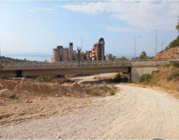
Αποκατάσταση του δρόμου και δενδροφυτεύσεις στο φρύδι του πρανούς
